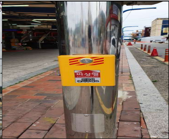
IP 비상벨 설치
