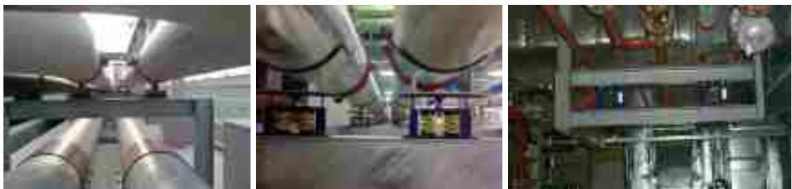
-변위조절이 가능한 방진마운트 수평배관 설치 모습-
